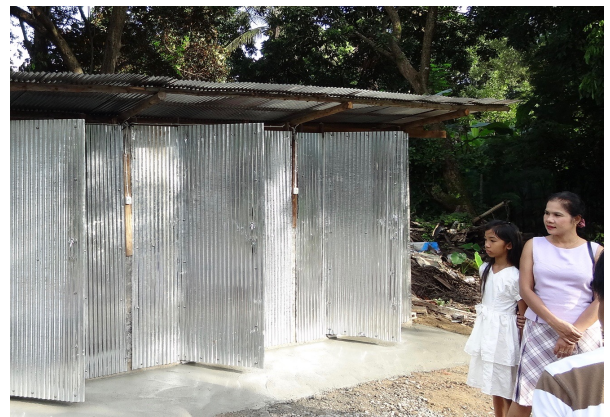
I servizi igienici terminati
