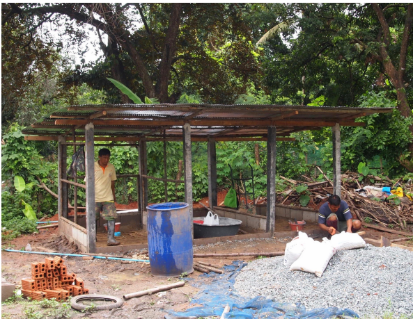
La costruzione dei servizi igienici
