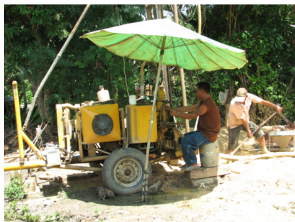
Lavori in corso al pozzo
